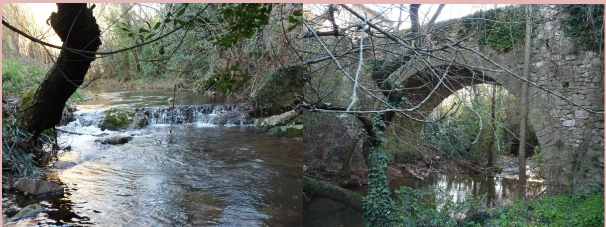
Le ruisseau de Courbezou et le pont du hameau des Douze, vus de GREEN'ING.
